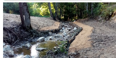
Photo avant (gauche) et après (droite) le dérasement du seuil AEP du Moingt (FDPMA42©)
